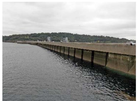
図11 ランス川河口の潮汐発電の堰堤
